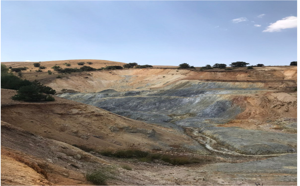
AÇIK İŞLETME SAHASINDA AÇILAN YARMAYA AİT GÖRÜNÜM
